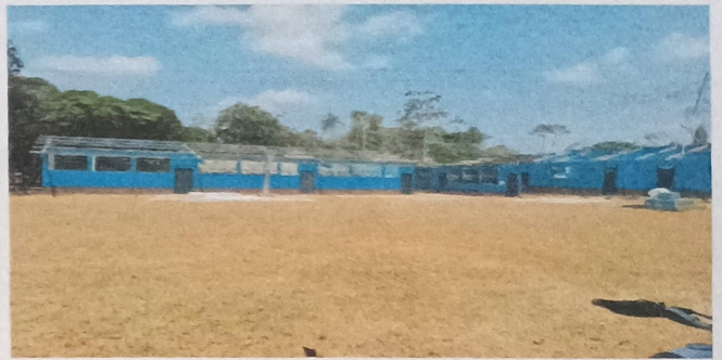
Foto 2: Desinstalacion de de techo modulo 2.
