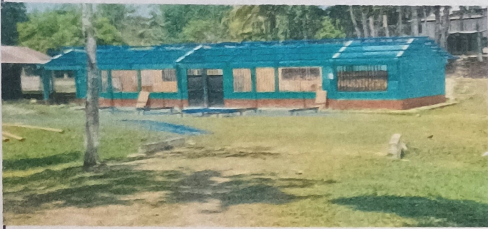
Foto 1: Desinstalacion del Modulo 1. en cuanto a techo.
