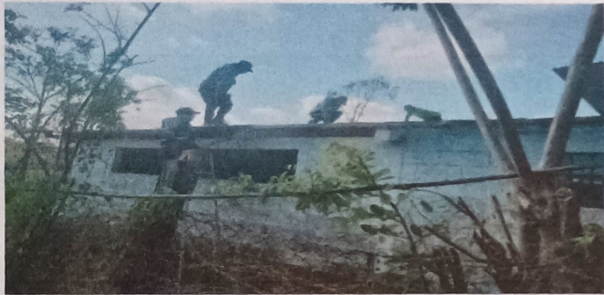
Foto 3: Desinstalacion de de techo modulo 3.
